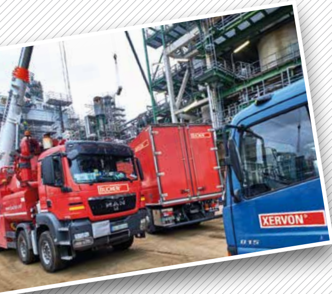
Bei Turnarounds sind umfangreiches Fachpersonal und hohe technische Kapazitäten gefragt
